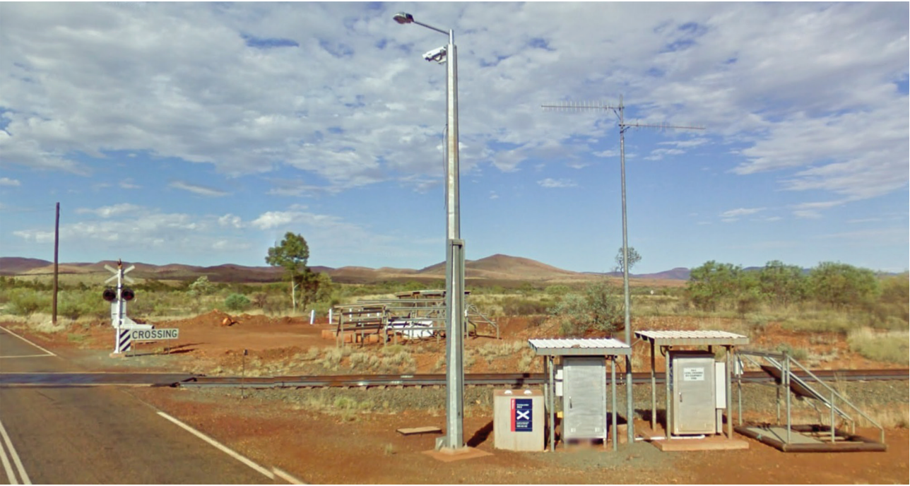
Рис. 1. Переезд, оснащенный средствами освещения, видеонаблюдения и лазерными системами обнаружения препятствий 2
