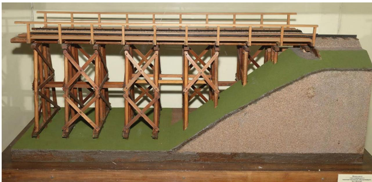
**Рис. 2.** Модель деревянного балочного моста конструкции, получившей распространение в конце XIX – начале XX вв., в том числе на железной дороге Санкт-Петербург – Москва (коллекция музея РУТ (МИИТ))
