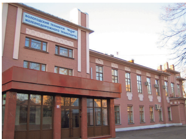
Рис. 2. Здание техникума, построенное в 1906 г., сейчас здесь размещается учебный корпус № 1
