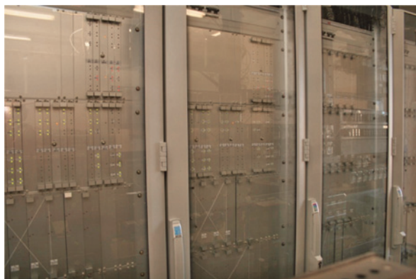
Рис. 2. Система микропроцессорной централизации МПЦ-МПК
