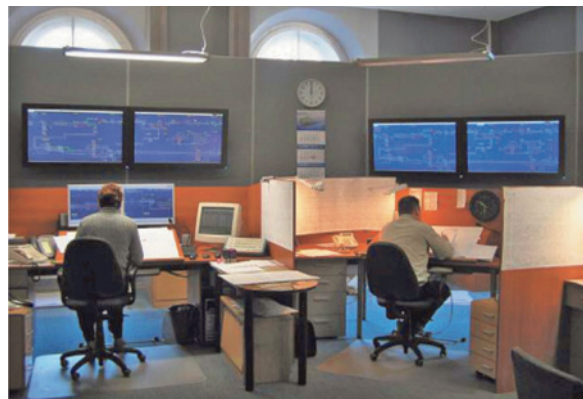
Рис. 4. Комплексная автоматизированная система диспетчерского управления метрополитена
