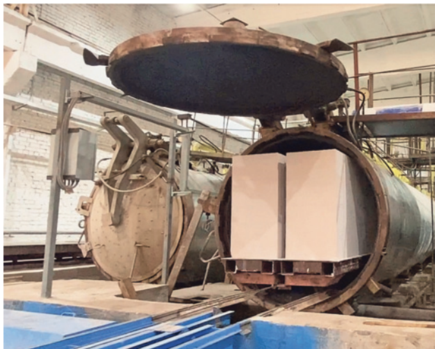
Рис. 6. Автоклав после завершения цикла гидро-термальной обработки газобетонного массива
