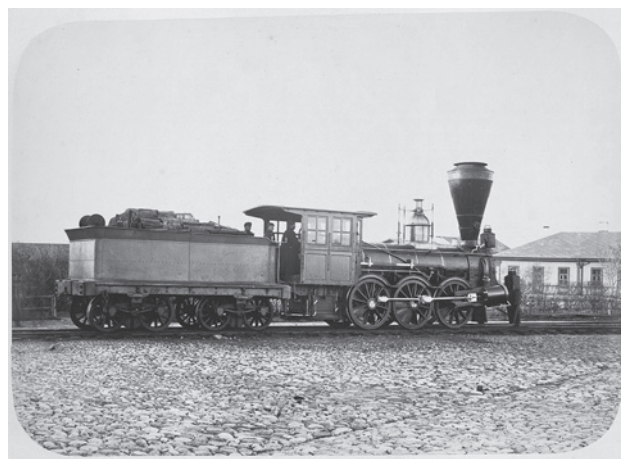
Рис. 1. Дровяной паровоз серии Г, построенный в 1863–1867 гг. на Александровском чугунолитейном заводе Санкт-Петербурга (ныне Пролетарский завод). Всего было построено 93 таких паровоза
