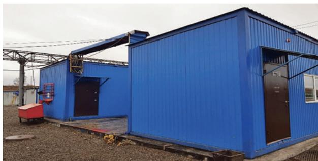
Рис. 10. Транспортный модуль восстановительного блокпоста для управления движением поездов при разрушении инфраструктуры
