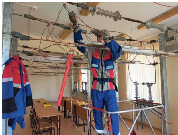
Рис. 1. Лаборатория «Устройство и ремонт контактной сети»
