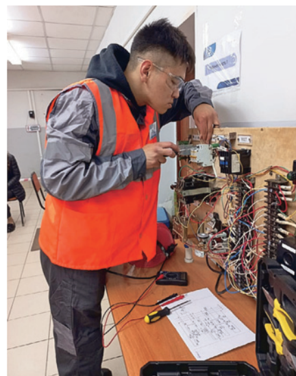
Рис. 2. Выполнение задания демонстрационного экзамена по специальности 13.02.07 «Электроснабжение (по отраслям)»
