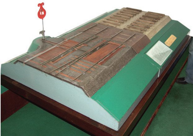
Рис. 10. Модель верхнего строения пути Николаевской железной дороги. 1851 г.
