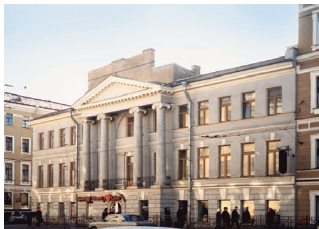
Рис. 5. Здание Военно-строительной школы (ныне – СПбГАСУ). 2003 г.
