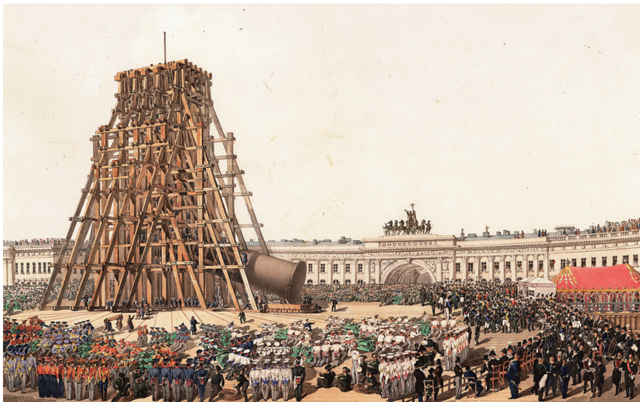
Рис. 7. Подъем колонны. Montferrand, Auguste Ricard de. Plans et détails du monument consacré à la memoire de l'Empereur Alexandre. – [S. l. : s. n.], [Non ante 1857]
