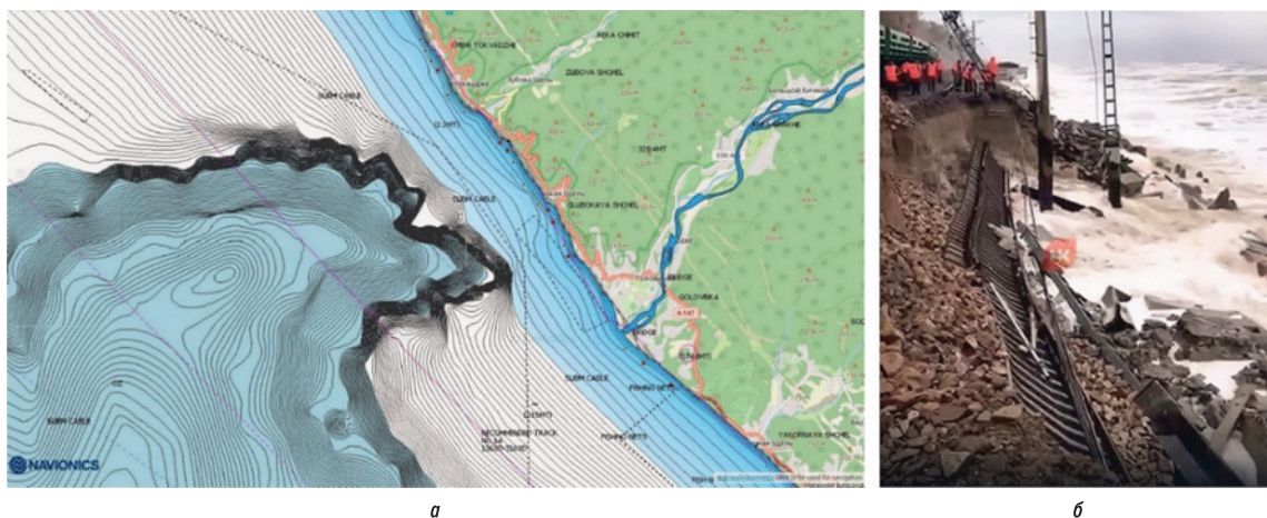
Рис. 1. Рельеф участка Туапсе – Адлер Северо-Кавказской железной дороги в районе п. Головинка (а) и последствия шторма 26.10.24 на перегоне Адлер – Хоста (б)
